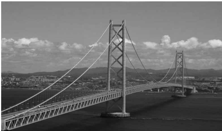
本州四国連絡高速道路ホームページより
