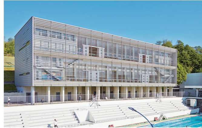
1 武道館 剣道・空手道の道場、会議や合宿もできる多目的ホールを備えます。和室や温水シャワーなど設備も充実。
